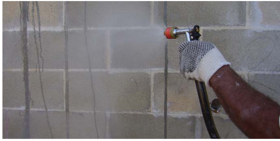
Figura 3 - Humedecer uniformemente la pared
